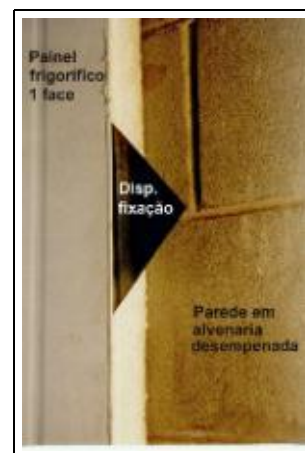
Detalhe da fixação Painel 1 face
